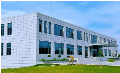
当升科技锂电材料工程技术研究院
